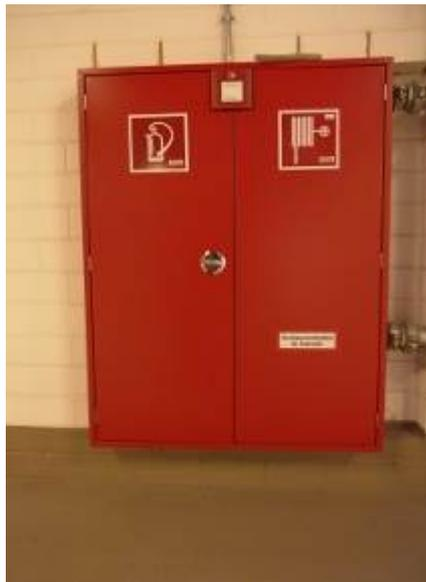
Abb. 30: Schrank mit Löschschlauch (Wandhydrant)
