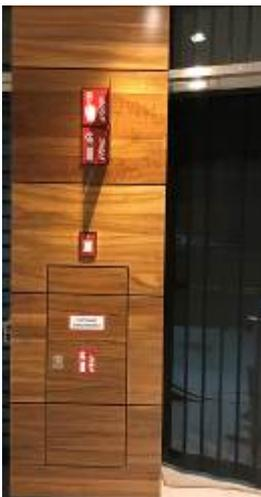
Abb. 26: Feuerlöscher in Wand eingebaut
