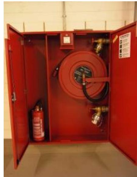
Abb. 31: Löschschlauch (Wandhydrant)
