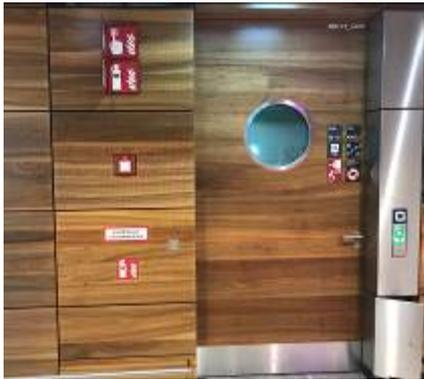
Abb. 27: Feuerlöscher in Wand eingebaut
