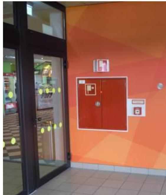
Abb. 33: Schrank mit Löschschlauch (Wandhydrant)
