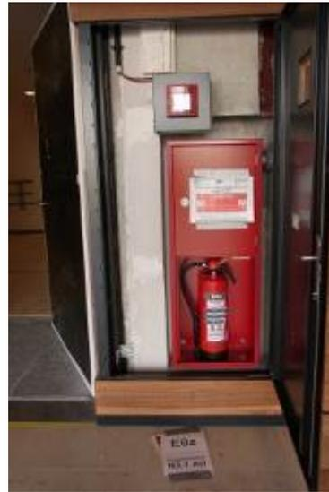
Abb. 28: Feuerlöscher hinter Wandverkleidung
