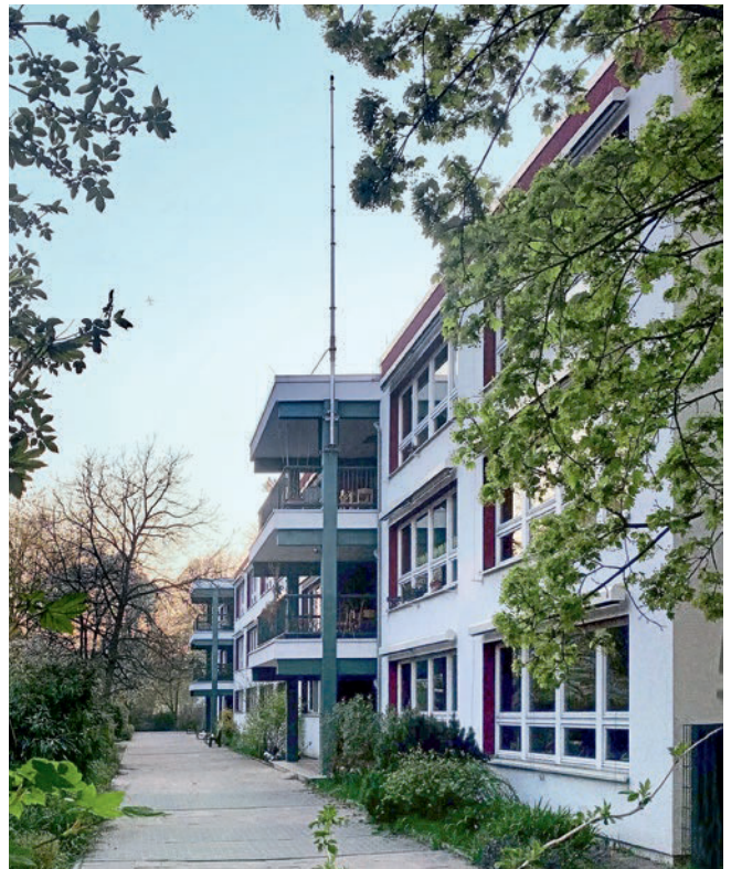
Eine der 31 stationären Messstellen befindet sich in Pankow. Links: Das FBB Messmobil in Rangsdorf.
