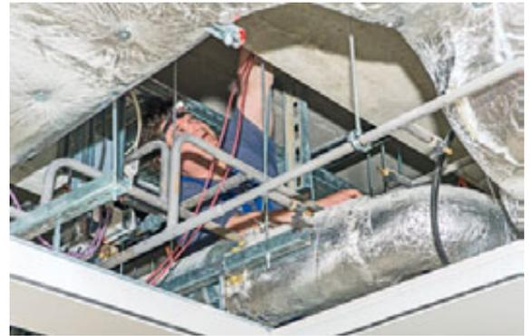
In den Zwischendecken werden die Kabel für den Umbau der Brandschutzanlage neu verlegt.
