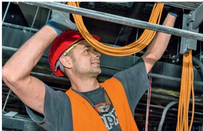
Im Deckenhohlraum verlegte Kabel und Kabeltrassen waren teilweise nicht abnahmefähig und werden nun abgeklemmt, zurückgebaut und nach den gültigen Vorschriften neu verlegt.
