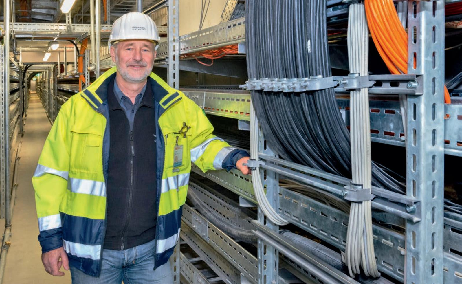
*Nach Berechnungen und Prüfung durch Sachverständige ist eine teure und zeitintensive Verlegung von Stromschienen vermeidbar. Die Sanierung der Hauptverkabelung erfolgte stattdessen über eine Mängelbeseitigung durch die Firmen. Die Arbeiten konnten Anfang Juni 2015 abgeschlossen werden.*
