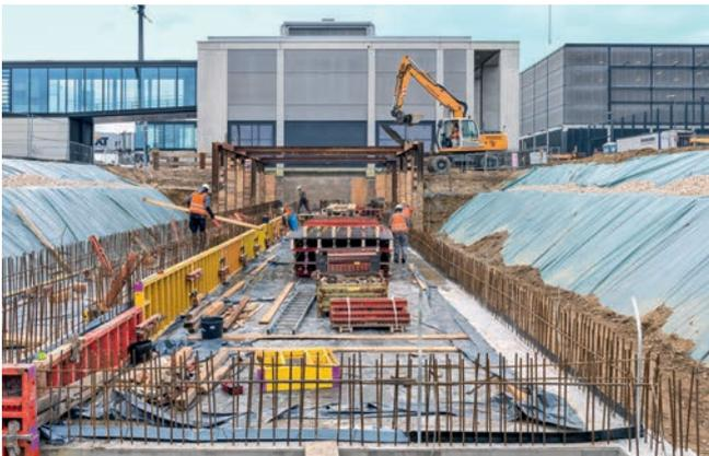
Am Pier Süd wird eine unterirdische Sprinkleranlage errichtet.
