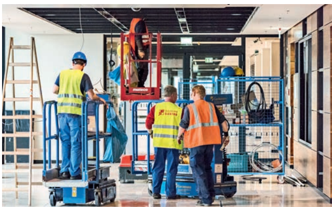
Die Firma Schulzendorfer Elektro installiert im Main Pier die Verkabelung für Rauchfenster.
