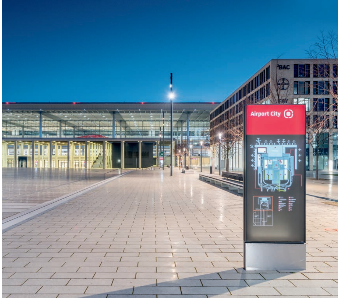
Das Bürogebäude in der Airport City direkt am Willy-Brandt-Platz
