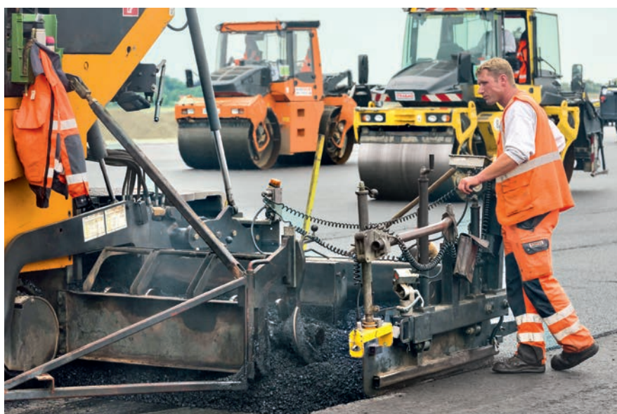
Bis zu 200 Bauarbeiter waren von Mai bis Ende September 2015 auf der Nordbahn im Einsatz. Mit rund 50 Großgeräten wie Abfräsmaschinen und Asphaltfertigern wurden die oberen beiden alten Asphalt-schichten entfernt und rund 220.000 Quadratmeter Asphalt neu aufgebracht.
