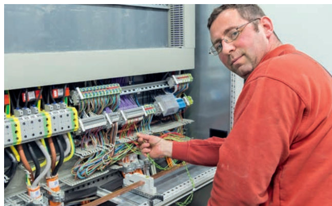
Für ein Segment der ÜSSPS werden Schwachstromleitungen angeklemt.
