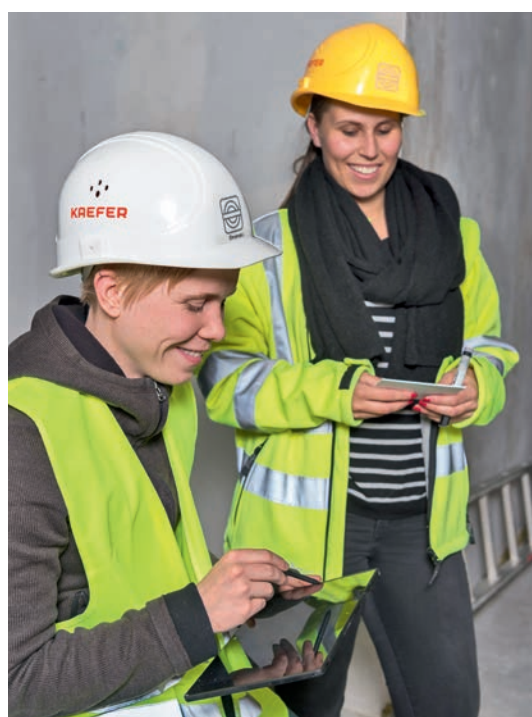
Zwei Ingenieurinnen der Firma Käfer bei der Dokumentation und Prüfung der eingebauten Brandschutzschotts.
