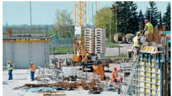
Die Bauarbeiten für das Interimsterminal des Regierungsflyghafens starteten Anfang 2017.
