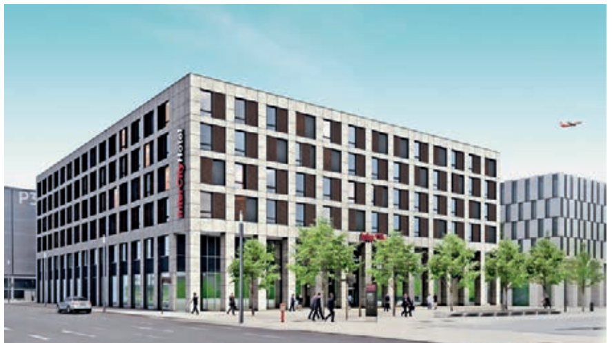
In der Airport City plant die Dietz Airport Hotels Grundbesitz GmbH ein neues Hotel.
