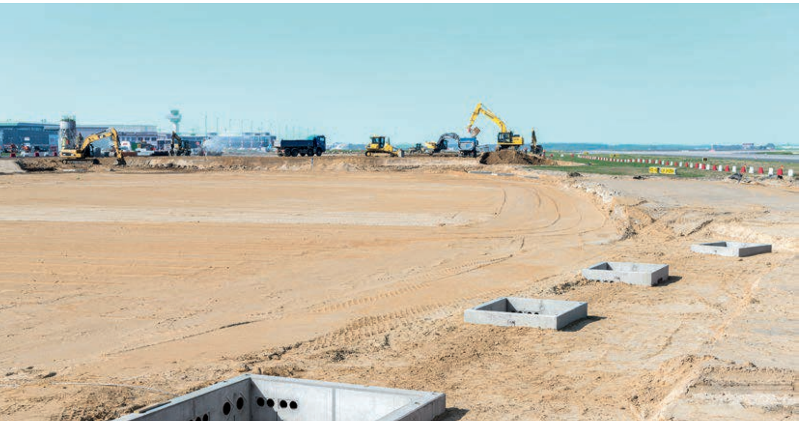
Der Taxiway Charlie wird im Rahmen des Projekts Flugbetriebsflächen verlängert.
