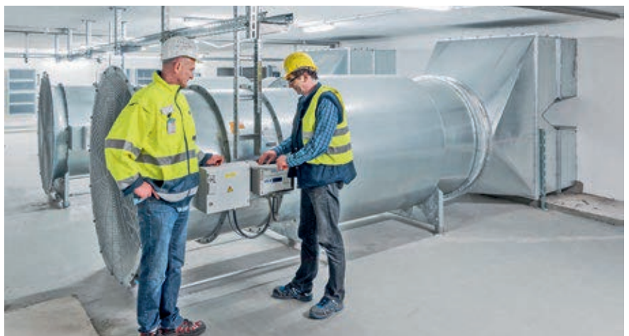
Kanäle für die Nachströmung im Lieferhof Süd
