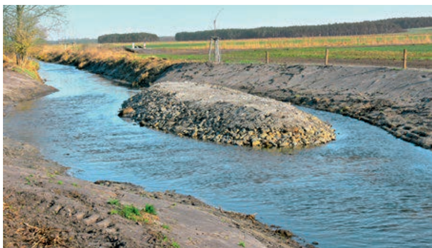
Die neu hergestellte Mittelinsel im Zülowkanal soll die Vielfalt der Gewässerstrukturen erhöhen und damit mehr Tier- und Pflanzenarten Lebensraum bieten.
