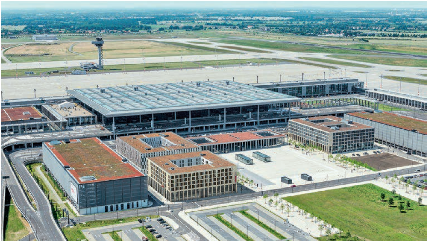
Blick in die Airport City in Richtung Westen. Das Hotel vorne links soll bis zur BER-Eröffnung realisiert werden.
