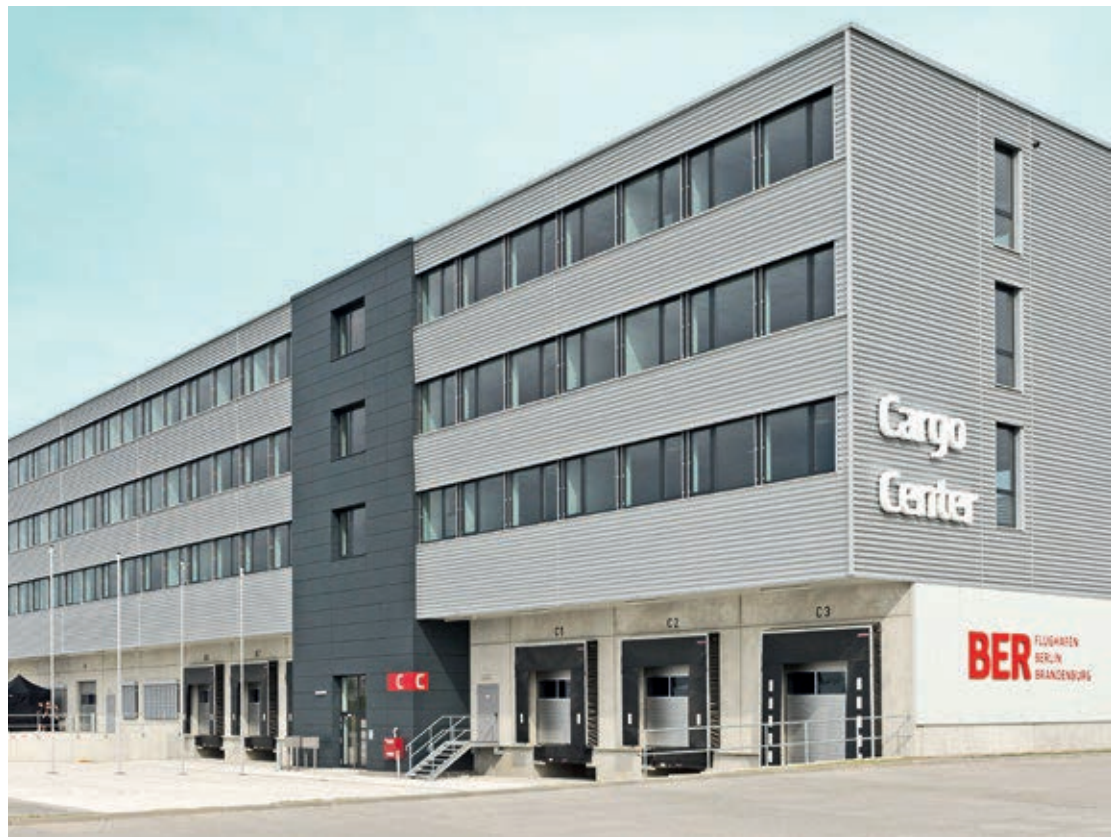
Das Cargo Center am BER ist bereits eröffnet.
