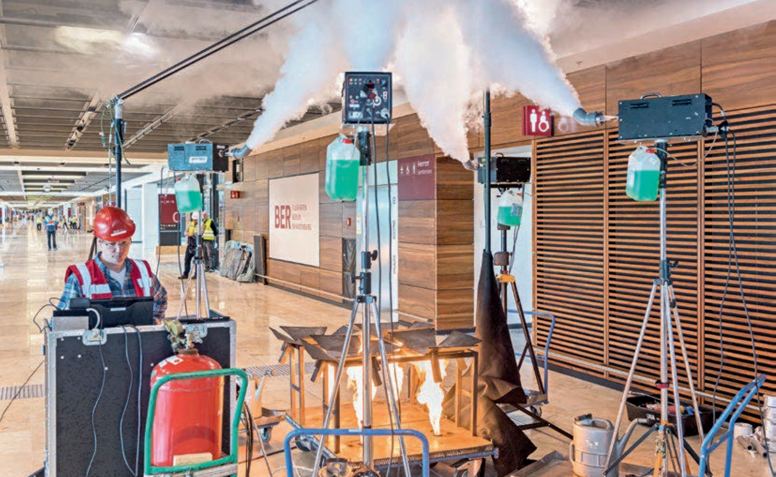
Seit Anfang 2017 werden im Rahmen der Technischen Inbetriebnahme Heißgasrauchversuche im Terminal durchgeführt.
