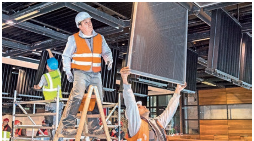
Arbeiten in den Deckenhohlräumen – diese sind inzwischen in großen Teilen abgeschlossen.
