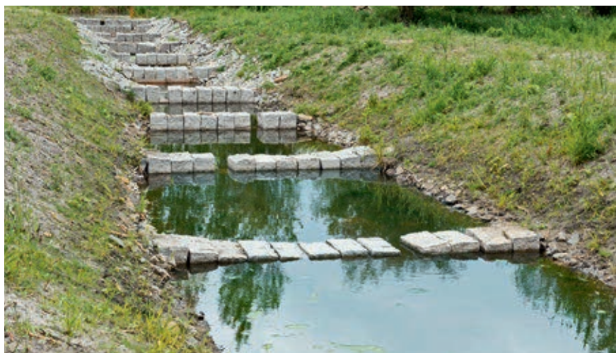
Fischtreppe am Rangsdorfer See im Jahr nach der Fertigstellung
