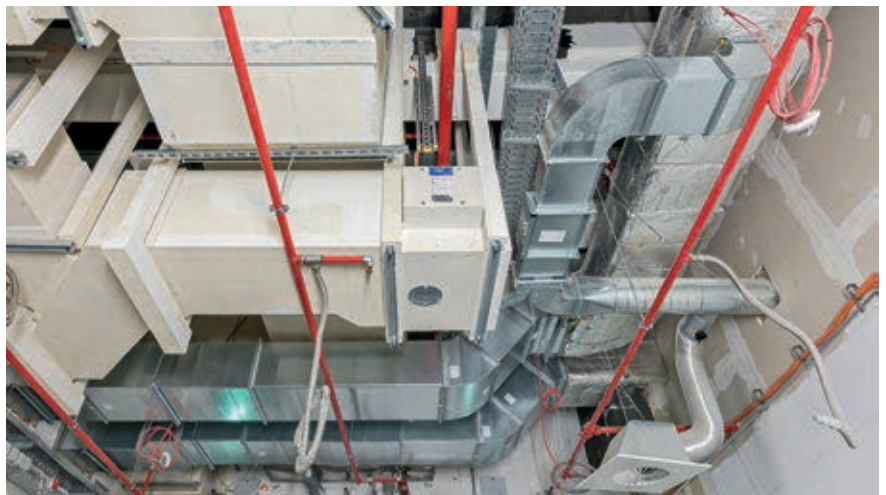
Nachgerüstete Entrauchungskanäle und Sprinkler, bevor die Zwischendecke eingezogen wird
