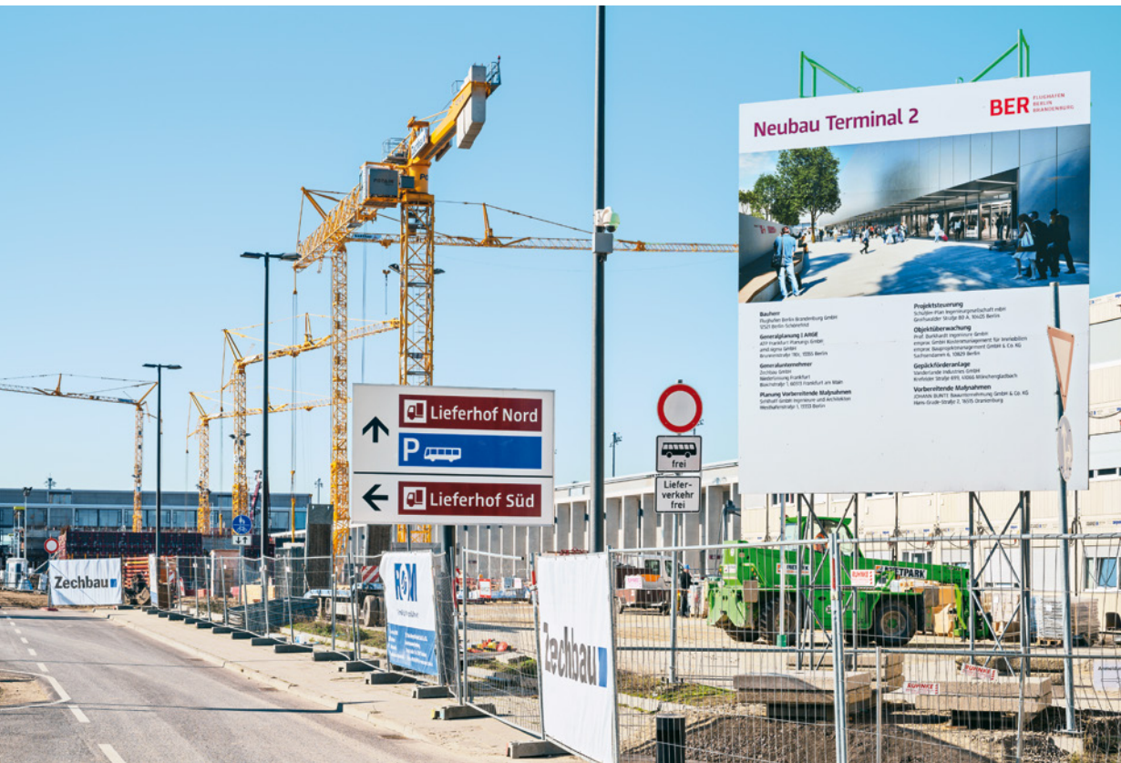
Noch im Bau: Das neue Terminal 2 ist ein Prozessergebäude mit Check-in, Gepäckaufgabe und -ausgabe, Sicherheitskontrollen und Einzelhandel sowie Gastronomie. Der Einstieg ins Flugzeug wird über das Pier Nord erfolgen.
