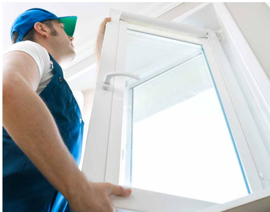
Die Eigentümer können nach der Zusage durch die FBB eine Baufirma ihrer Wahl mit der Umsetzung der Schallschutzmaßnahmen beauftragen.
