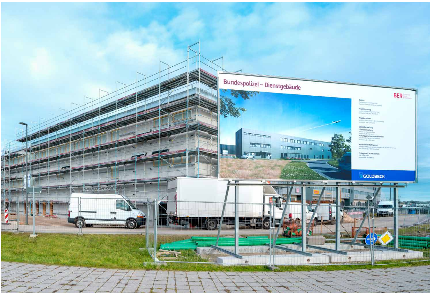
In unmittelbarer Nähe zu den Terminals T1 und T2 entsteht derzeit das Dienstgebäude der Bundespolizei. Die Inbetriebnahme der Dienststelle soll im Sommer 2020 erfolgen.
