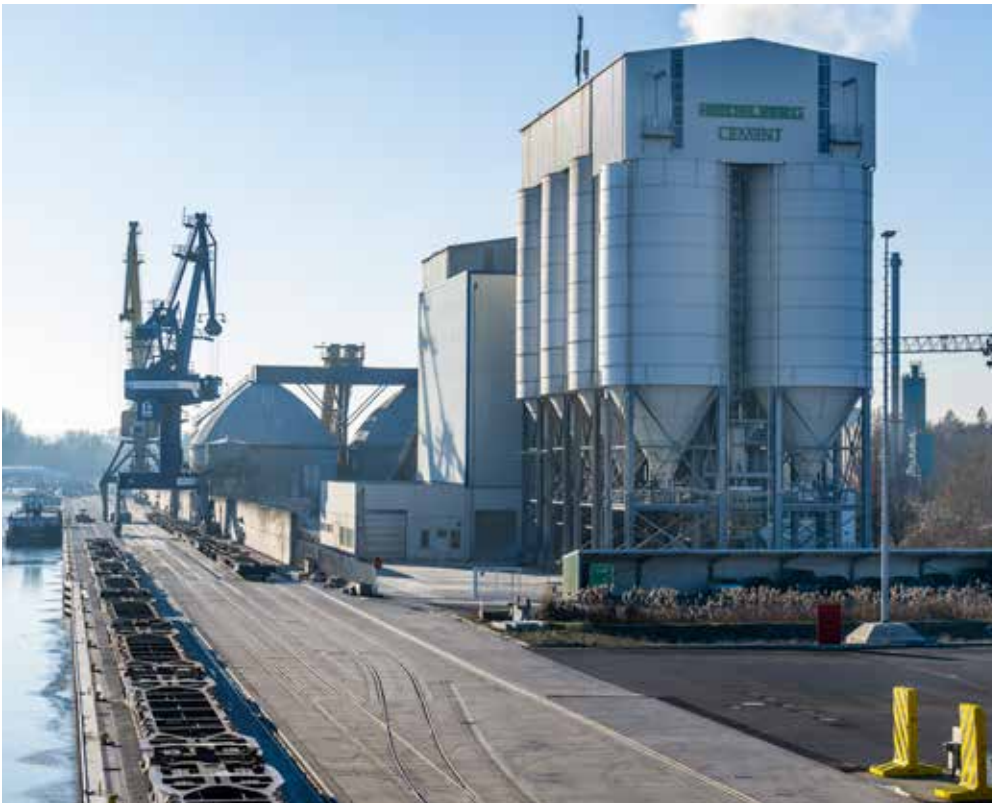
Blick auf den Nordkai mit Hafenkränen, Ladegleisen und Zementwerk
