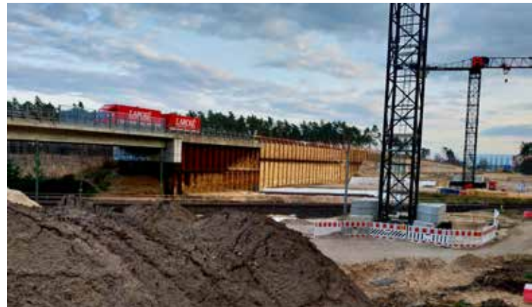
Unmittelbar neben der Autobahnbrücke der A117 über die Schienenanbindung Ost des BER haben die Arbeiten für die neue Anschlussstelle Hubertus begonnen.
