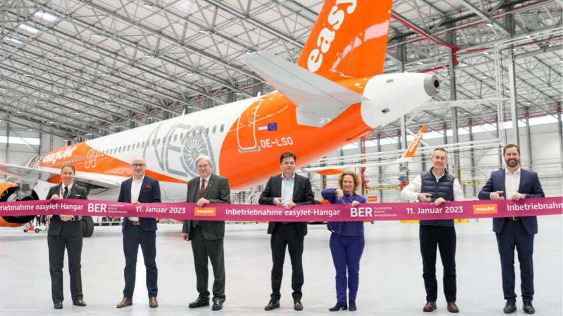
Im Januar 2023 wurde der easyJet-Wartungshangar in der Maintenance Area des BER eröffnet.
